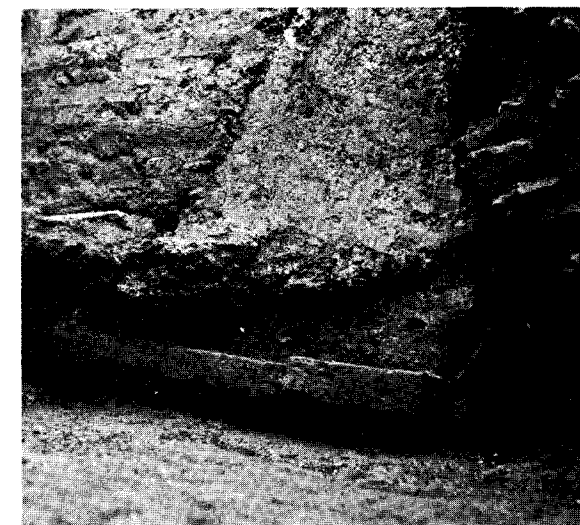
Fig. 46. — Zona B della taberna , angolo SO, da N: tratto conservato di muro del 6° periodo, fase II, cui si addossa il muro della fase III.
