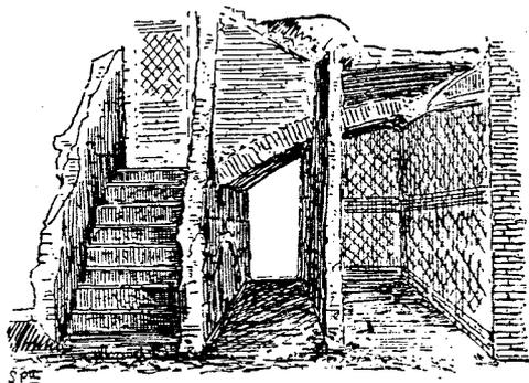
Fig. 83. - Una scaletta a tre rampe.
